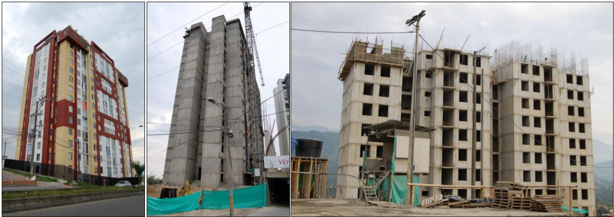
Figura 1. Vista de los edificios de muros delgados de interés
