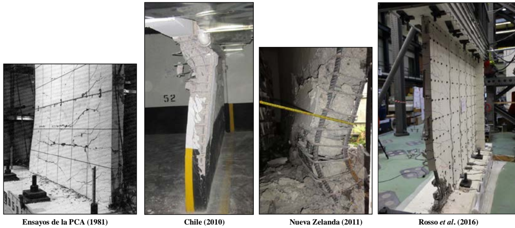
Figura 10. Evidencias en laboratorio y campo de inestabilidad lateral de muros delgados de concreto reforzado.
